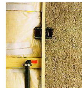
壁の中の様子 グラスウール(左) セルロース(右)
